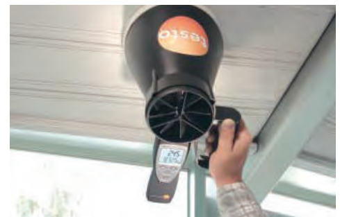
Мониторинг приточной вентиляции на потолочных и тарельчатых диффузорах
