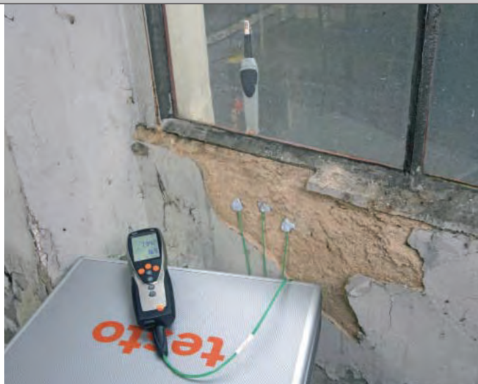
Измерение коэффициента теплопередачи U стены перед проведением ремонта, используя U -зонд и беспроводной зонд температуры/влажности (альтернативно возможно использование стандартного зонда температуры с кабелем)
